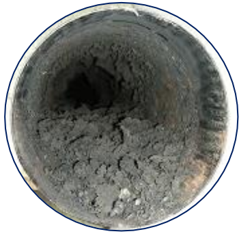
Fig.1 Depósitos de hollín
